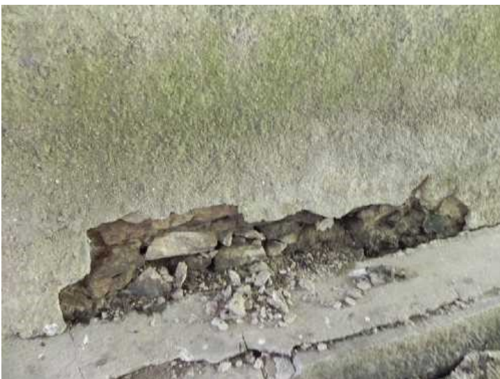
Detail – podpěra č. 2 – opadaná krycí vrstva nástřiku betonu, kameny nevykazují žádný problém – pouze ojediněle vypadaná spárová hmota
