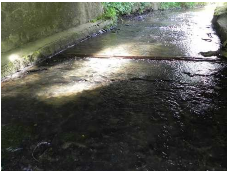
Dno pod mostem – tvořeno lomovým kamenem, zádlažbou se třemi příčnými podélnými prahy
